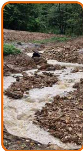
Canal de délestage du Fonceau après la crue
