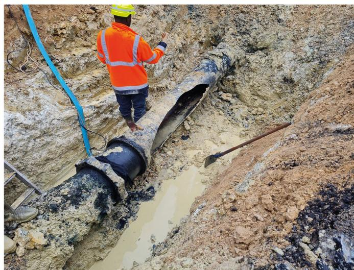
Fuite d'eau marquante sur le réseau de transport à Créteil. Pas de manque d'eau grâce au maillage et interconnexion.
