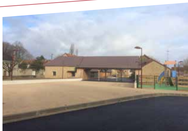
L'espace culturel & associatif, édifié en 2012-2014, avec un emprunt de 1,5 millions d'€, dispose de nombreux espaces dont une médiathèque, deux salles polyvalentes, un local médical afin de maintenir une offre de santé sur la commune.
